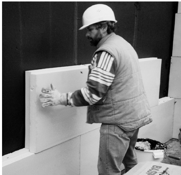
Bild 2: Verlegung der Dämmplatten im Verband
