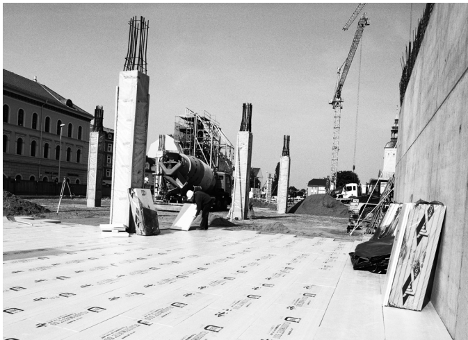
Bild 3: Perimeterdämmung unter Gründungsplatte mit XPS
