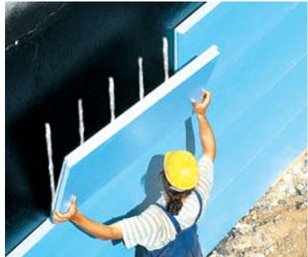
Abb. 08 » Verlegung der ROOFMATE Dämmung auf der abgedichteten Kellerwand
