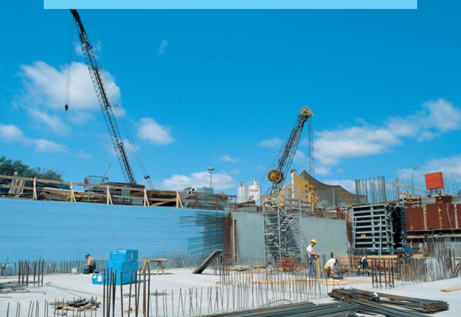
Abb. 03 » Die an der Spundwand befestigten Perimeter-Dämmplatten werden beim Betonieren der Kelleraußenwand als verlorene Schalung genutzt.
