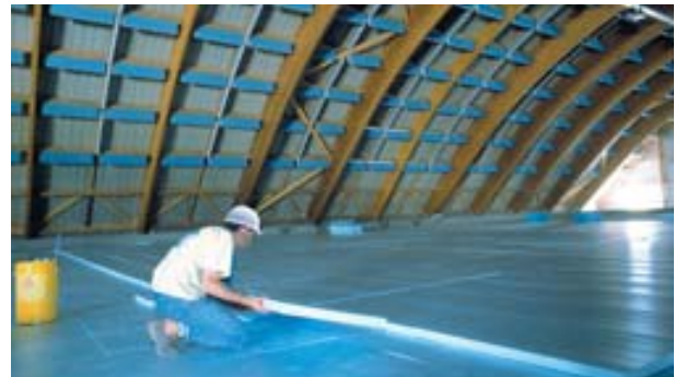
Abb. 35 » FLOORMATE Bodendämmung in einer Sporthalle
