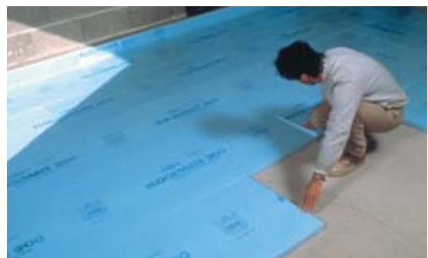
Abb. 36 » Die FLOORMATE 200-A Dämmplatten werden dicht gestoßen und lose verlegt.
