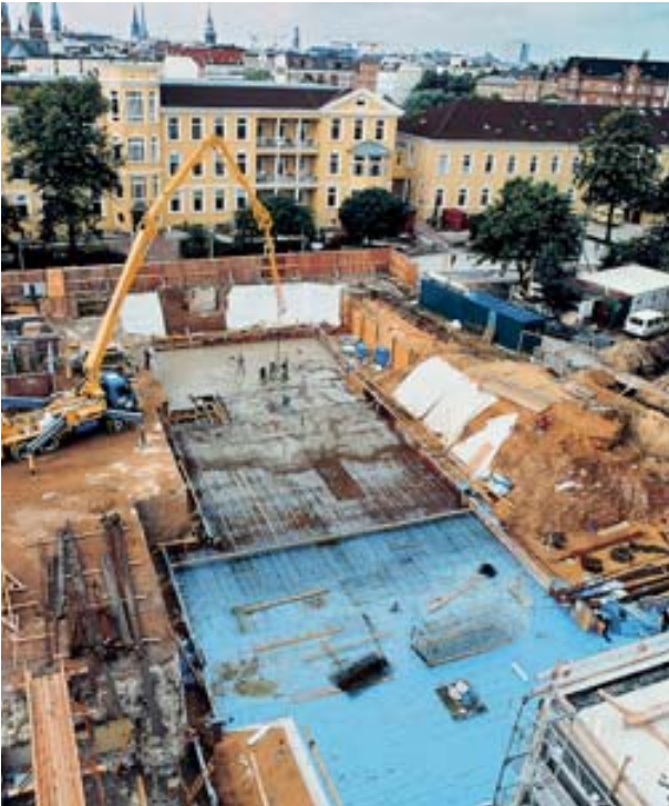
Abb. 25 » Die FLOORMATE Dämmplatten sind auch während der Bauphase hochbelastbar.
