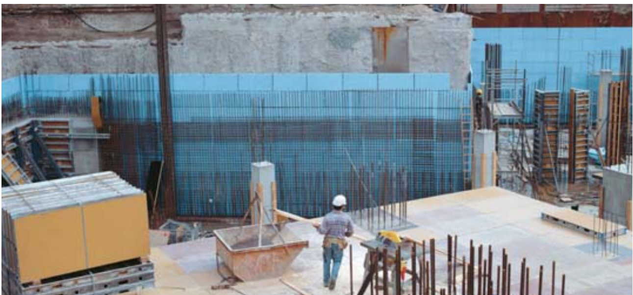
Abb. 20 » Die Perimeterdämmplatten sind am Verbau befestigt und werden als verlorene Schalung genutzt.
