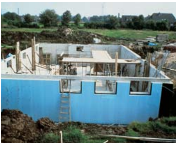
Abb. 05 » Wärmeschutz rundum und wärmebrückenfrei – Kelleraußenwand mit ROOFMATE Dämmschicht
