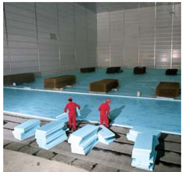
Abb. 30 » FLOORMATE Bodendämmung in einem Kühlhaus
