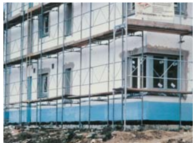
Abb. 32 + 33 » Widerstandsfähige Wärmedämmung aus XPS im Sockelbereich: WALLMATE WB-A Dämmplatten
