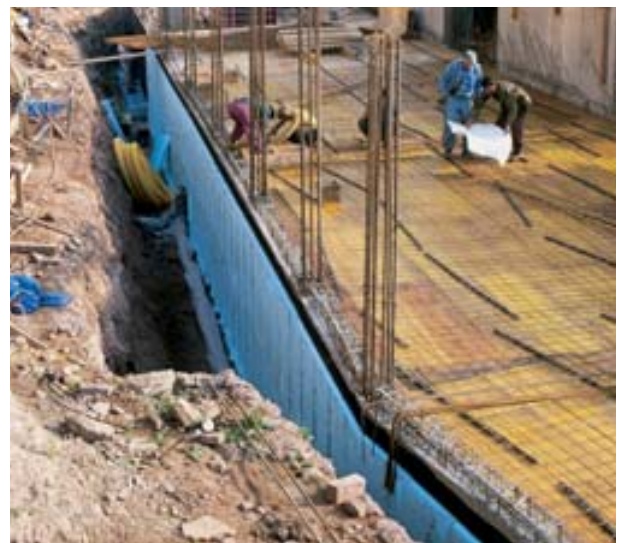
Abb. 17 » Einsatz von PERIMATE DI-A in über 8 Meter Einbautiefe
