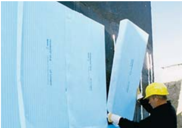
Abb. 15 » Verlegung der PERIMATE DI-A Dämm-/Dränelemente
