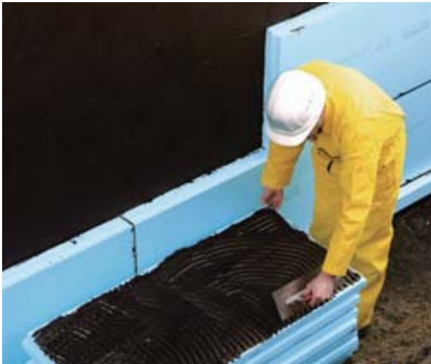
Abb. 18 » Vollflächige Verklebung der ROOFMATE Dämmung
