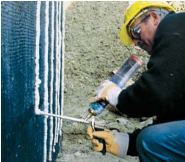
Abb. 10 » Aufbringen des INSTA-STIK Perimeterklebers
