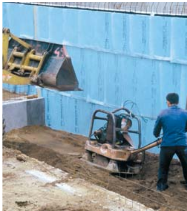
Abb. 23 » Das Füllmaterial kann mit schwerem Gerät verdichtet werden.
