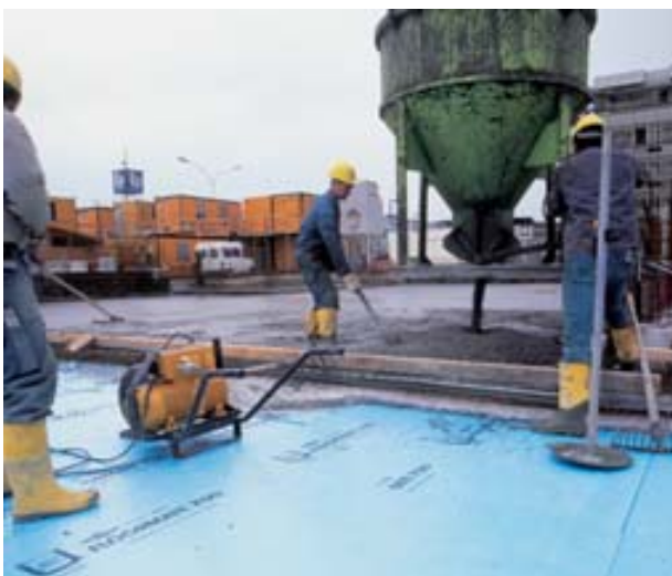
Abb. 24 » Betonierarbeiten auf FLOORMATE Wärmedämmschicht
