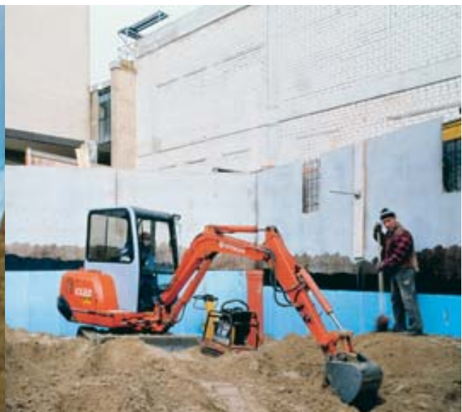
Abb. 14 » Die Verfüllung des Arbeitsraums kann mit großem Gerät durchgeführt werden
