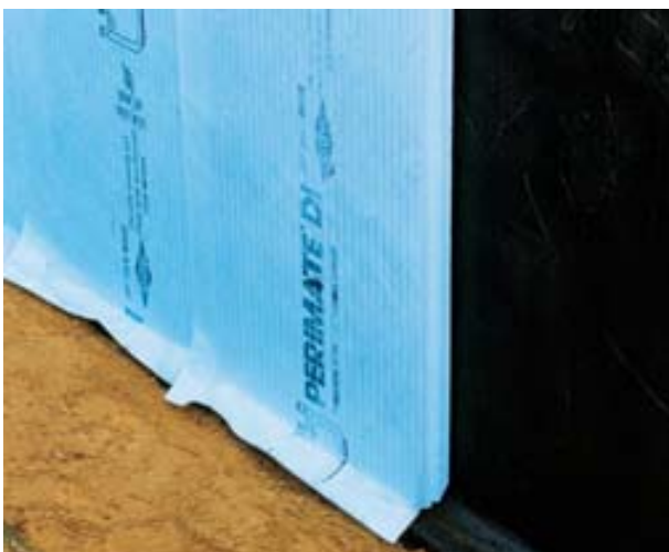
Abb. 16 » Am Fußpunkt stehen die PERIMATE Platten auf dem Fundamentvorsprung
