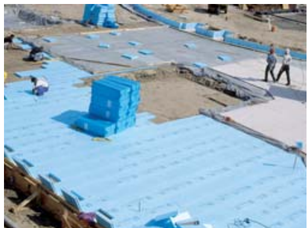
Abb. 27 » FLOORMATE Dämmplatten werden lose auf der Sauberkeitsschicht verlegt
