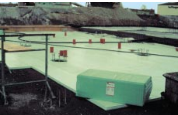
Bild 15: XPS unter lastabtragender Bodenplatte
