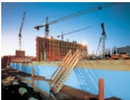
Bild 7: XPS als Perimeterdämmung unter der Bodenplatte
