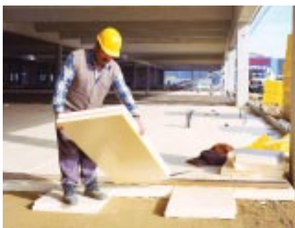
Bild 7: XPS als Perimeterdämmung unter der Bodenplatte
