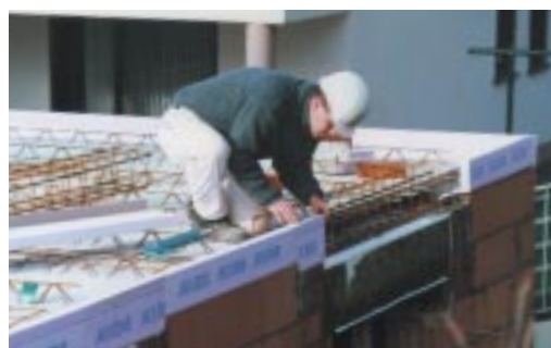
linkes Bild 8: XPS als Wärmebrückendämmung
