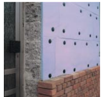
Bild 11: XPS als Kerndämmung im zweischaligen Mauerwerk
