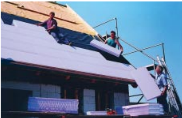
Bild 13: XPS im Steildach
