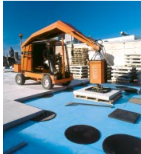
Bild 12: XPS als Parkdeckdämmung
