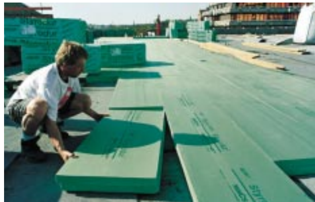
Bild 14: XPS im Umkehrdach
