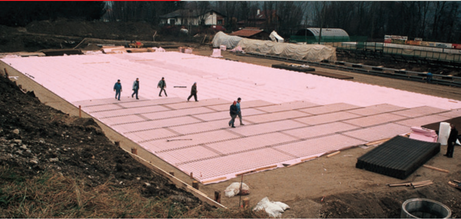
Wärmedämmung unterhalb von lastabtragenden Fundamentplatten.
