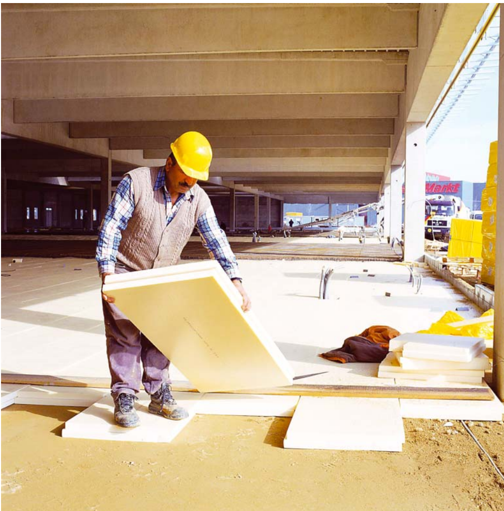
Bild 10: Verlegung der Perimeterdämmung unter der Bodenplatte.
