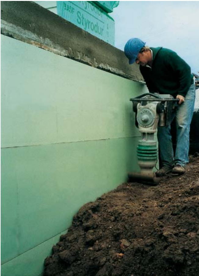
Bild 9: Lagenweise Verdichtung
