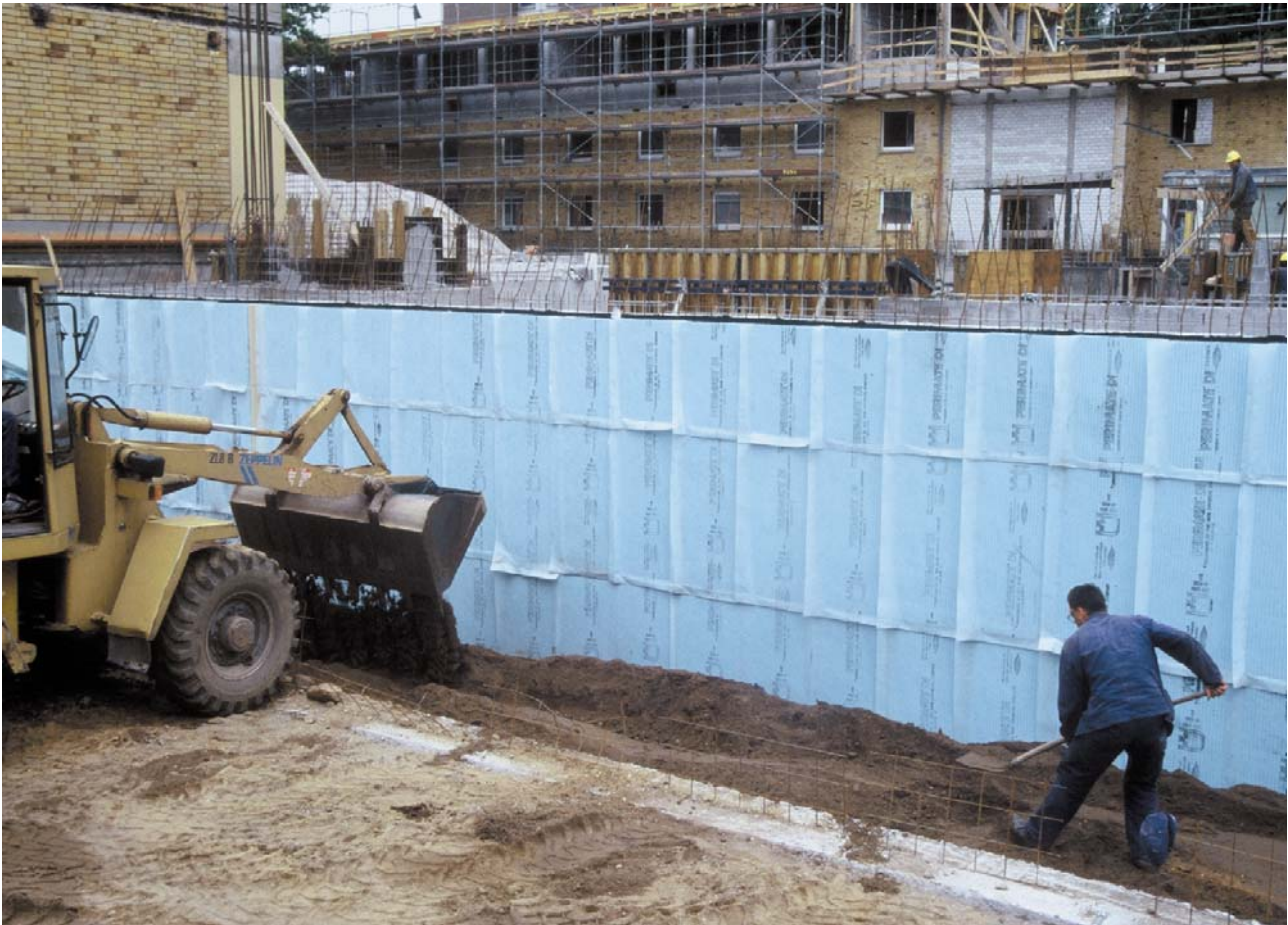
Bild 7: Einbau von Perimeterdämmplatten aus XPS mit integrierten Dränrillen und außenseitigem Filtervlies.
