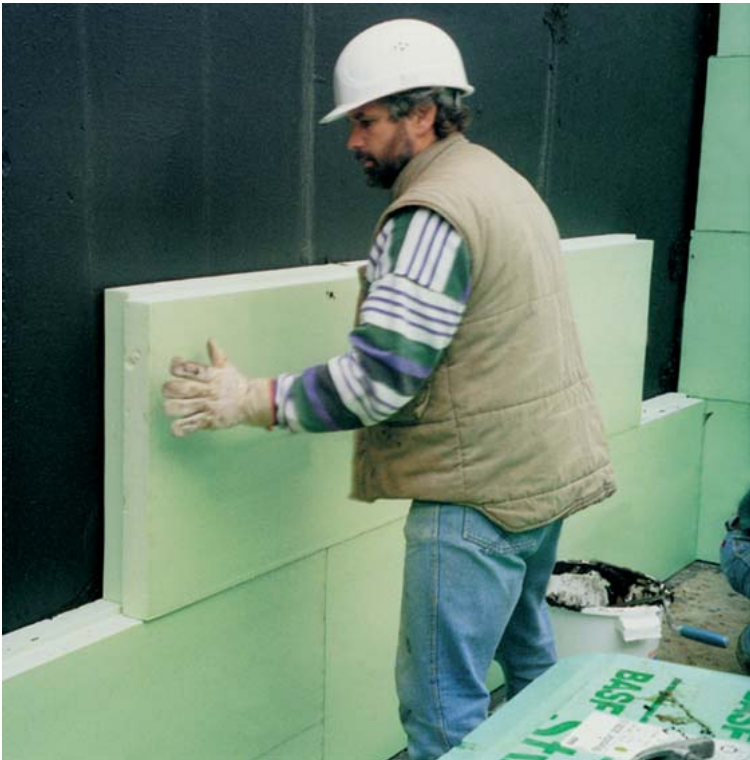
Bild 4: Verlegung der Dämmplatten im Verband.
