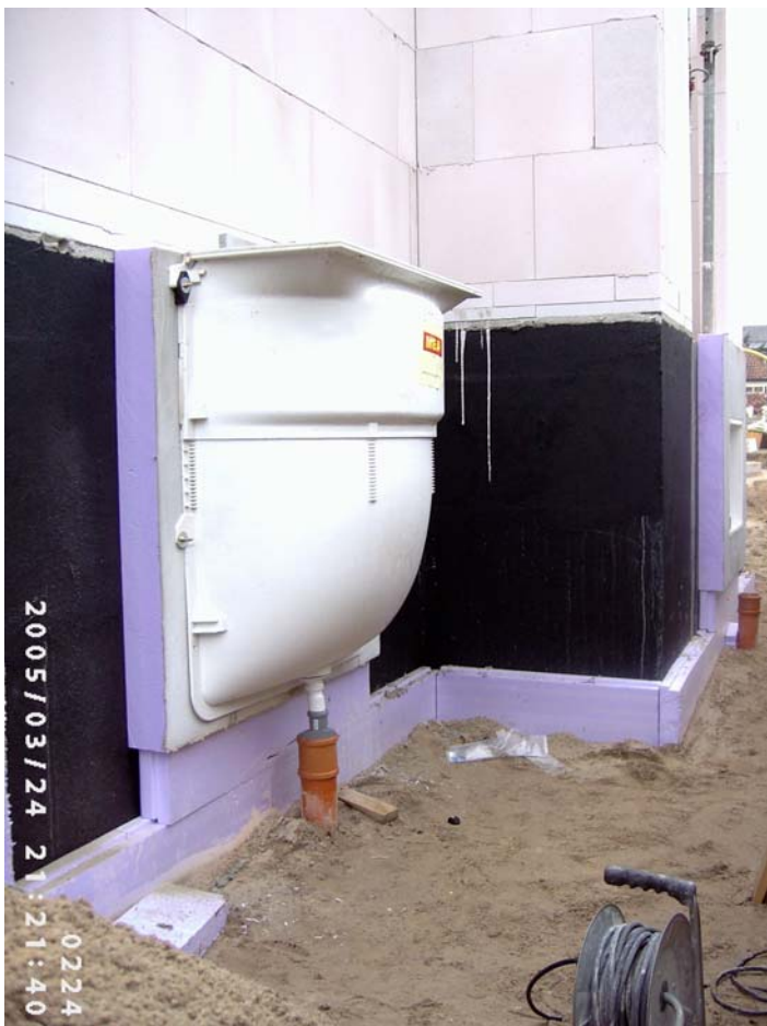
Bilder 5: Wärmebrückenfreie Installation der Lichtschächte.
