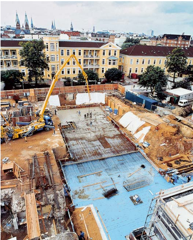
Bild 12: Perimeterdämmung unter Gründungsplatte mit XPS
