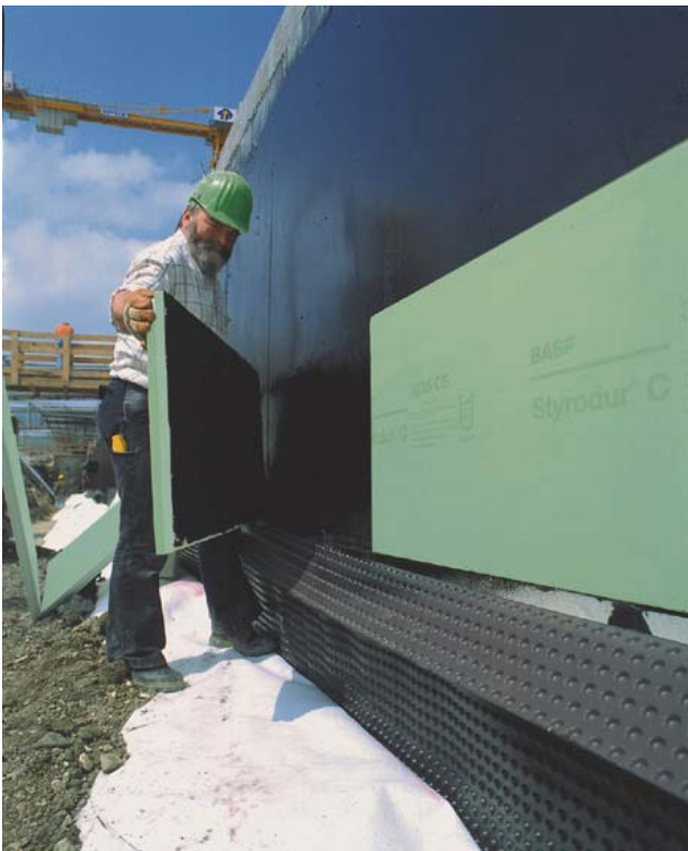
Bild 11: Vollflächige Verklebung der Dämmplatten
